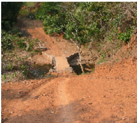
pont sur la Loukouni réhabilité par MSF
