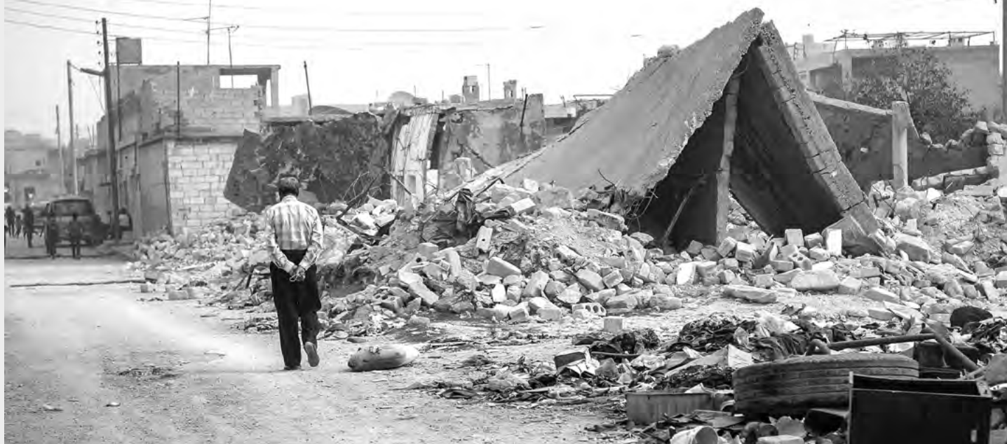
Alto grado de daños, destrucción y desplazamiento en Aleppo. Fotografía: ACNUR/Antwan Chnkjji, octubre de 2018
